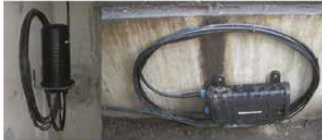
Exemple de lovage et de boîte d'épissures (BPEO)
